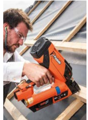
Krycie dachu – łąty, kontrłaty
