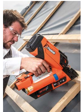
Krycie dachu – łąty, kontrłaty
