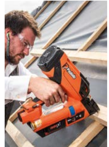
Krycie dachu – łąty, kontrłaty
