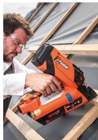
Krycie dachu – łaty, kontrłaty
